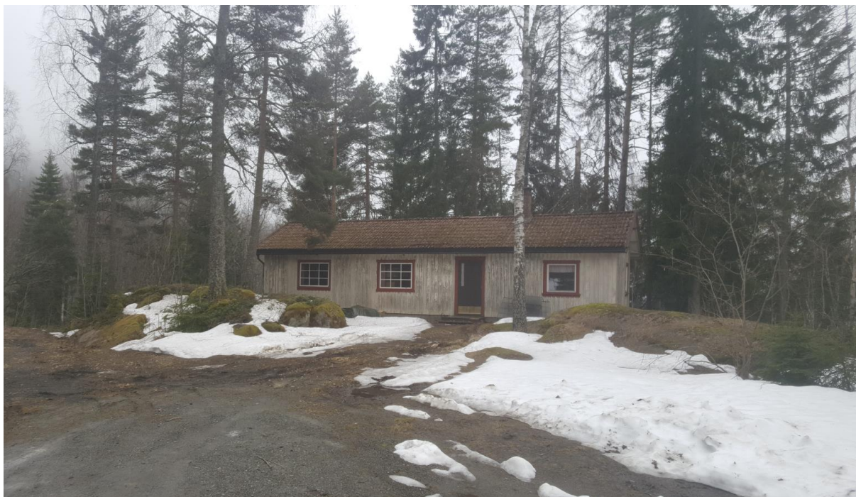
Figur 14 - Det gamle skytterhuset ved Reistadlia skytebane. Enkelte større trær står igjen rundt huset, ellers er området preget av tidligere hogst og ungskog.
