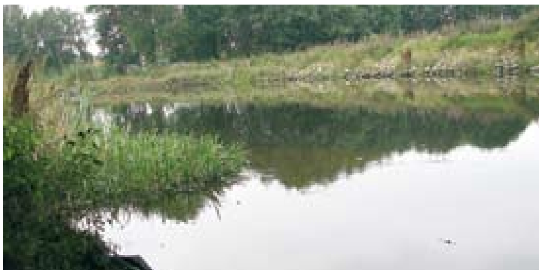
Forbygning av Lierelva sør for rv. 23
