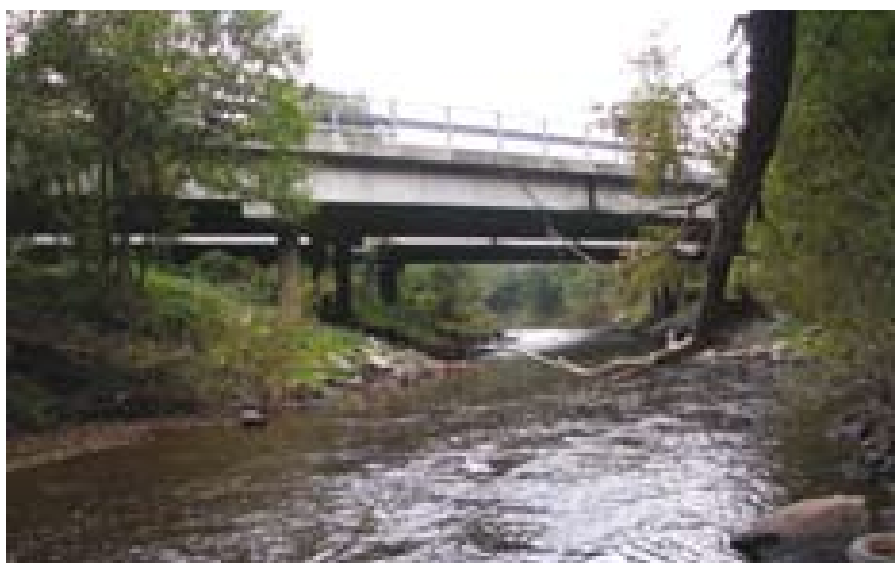
E18 på bro over Lierelva ved Kjellstad.
