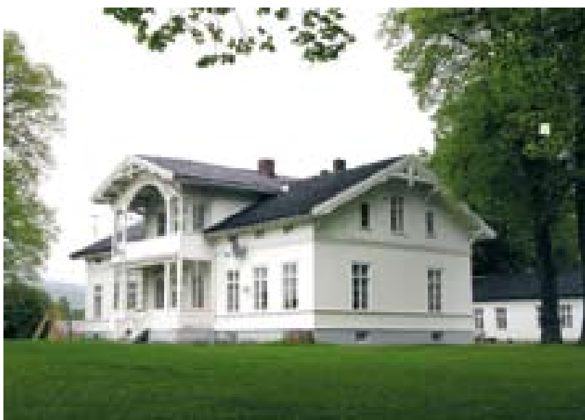
Hovedbygning på Gilhus gård, eksempel på første generasjons Sveitserhus fra 1865.
