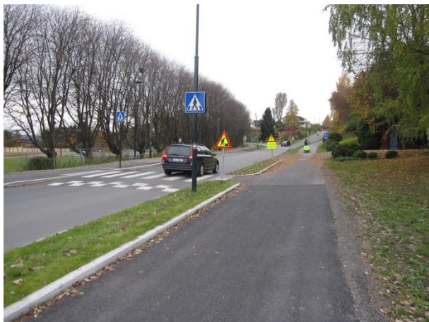
Figur 14: Ved Hegg skole. Her er det behov for veivisning for å styre sykklistene inn på riktig side avhengig av målpunkt videre.
