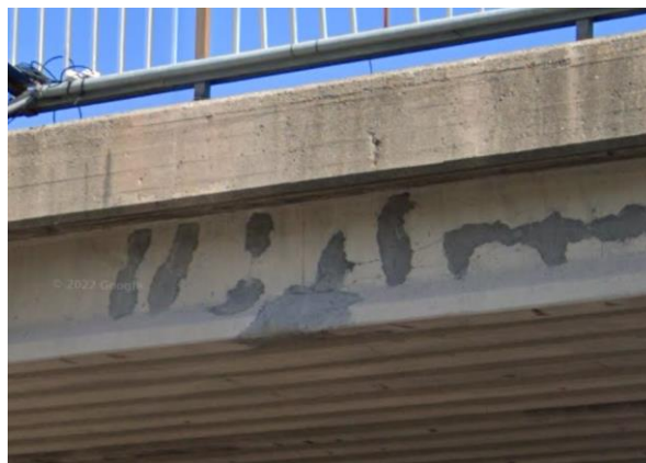
Figur 12 Tidligere utbedret påkjøringsskade på ytterste prefabrikeerte bjelke på vestsiden.
