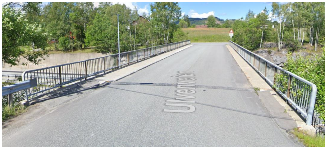
Figur 2 Heiatoppen vegbru med betongfortau.
