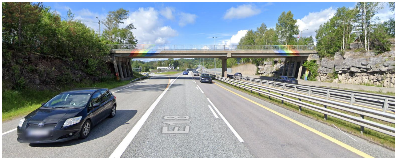
Figur 14 Østlig side av Heiatoppen bru med bergskjæring på begge sider av E18.
