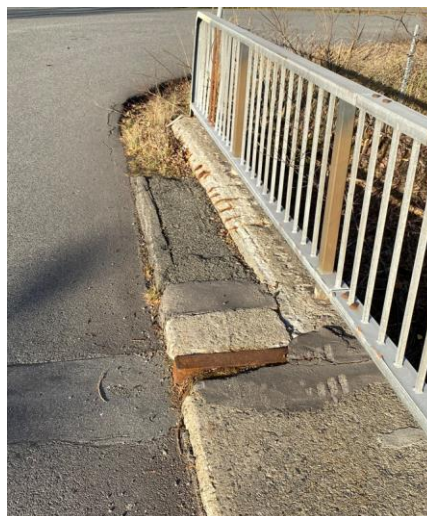
Figur 10 Til venstre: Vestlig betongfortau med avdekkede trekkerør til venstre, skade nr. 3. Til høyre: Østlig bankett og kantdrager. Korrodert rekkverk, skade nr. 7. Korroderende armering på kantdrager, skade nr. 9.
