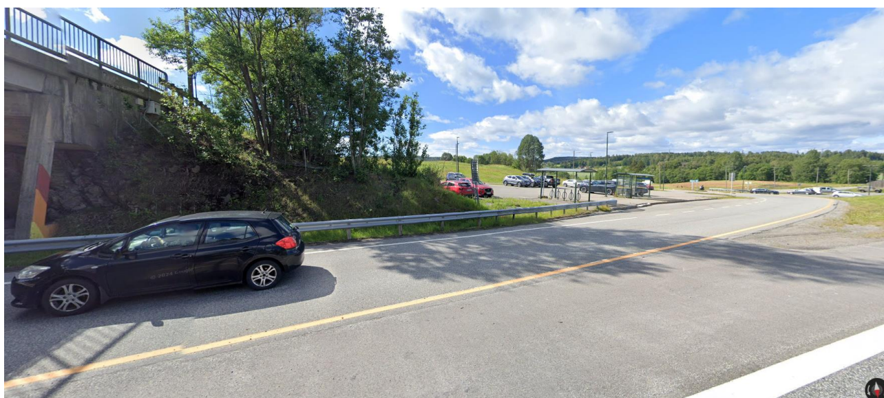
Figur 15 Sørlig ende av Heiatoppen bru med skråning ned mot P-plass og nordgående påkjøringsrampe til E18.
