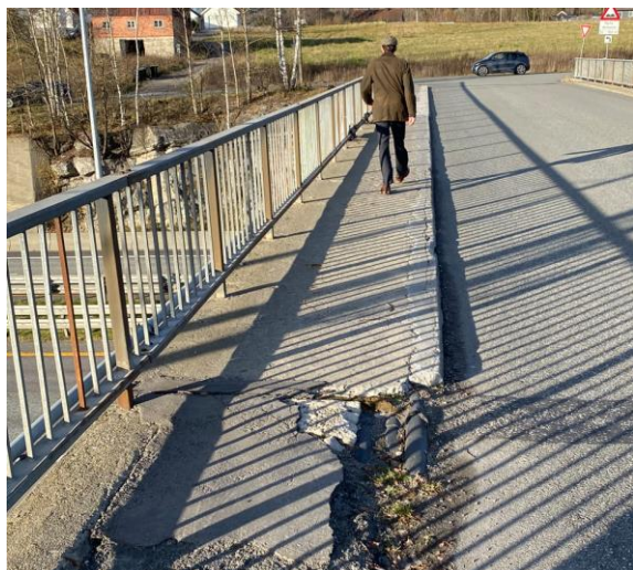
Figur 10 Til venstre: Vestlig betongfortau med avdekkede trekkerør til venstre, skade nr. 3. Til høyre: Østlig bankett og kantdrager. Korrodert rekkverk, skade nr. 7. Korroderende armering på kantdrager, skade nr. 9.
