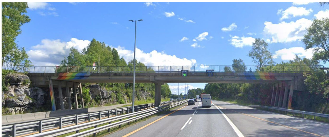
Figur 3 Heiatoppen vegbru sett i retning med nordgående kjørefelt.
