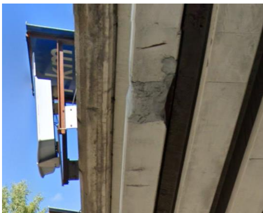
Figur 12 Tidligere utbedret påkjøringsskade på ytterste prefabrikeerte bjelke på vestsiden.
