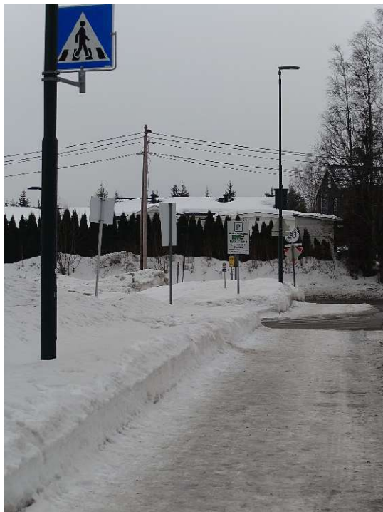
Uoversiktlig punkt mellom Ovenstadveien og parkeringsplassen tilhørende Ovenstadveien 5A-5H da en stor carport sperrer sikten. Situasjonen forverres av dårlig snørydding.
