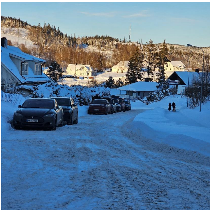
Tveita gangbru over Drammensveien: Rekkverk til gangbru er råttent. Store skumle hull, masse mangler.
