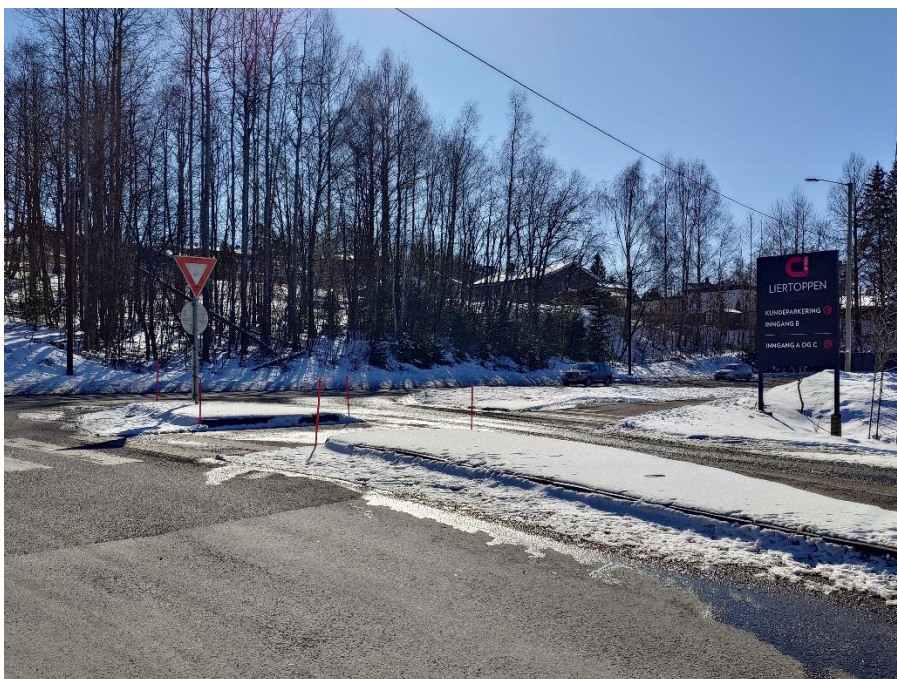
Krysset Gamle Drammensvei ved Råstoff: Vikepliktskiltet står 90 grader ute av stilling.
