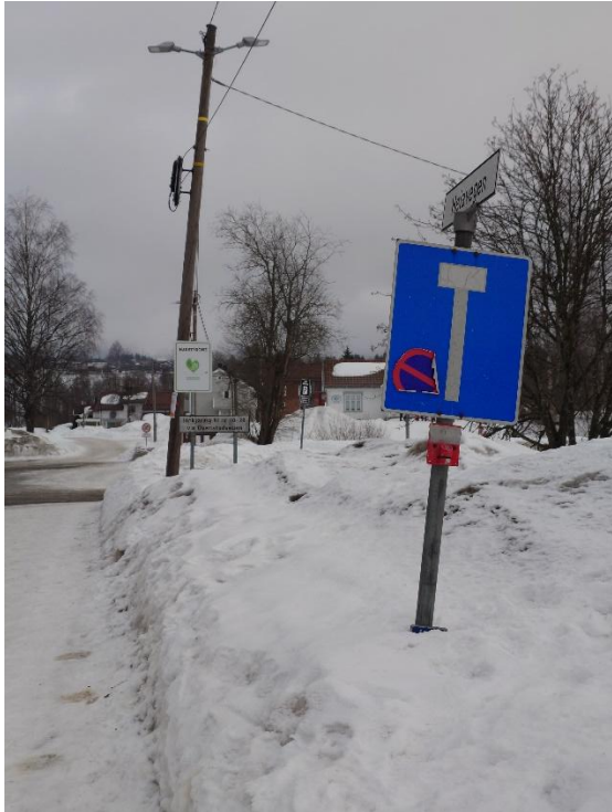
Rypeveien: Skolevei-skiltet er vridd ut av stilling.
