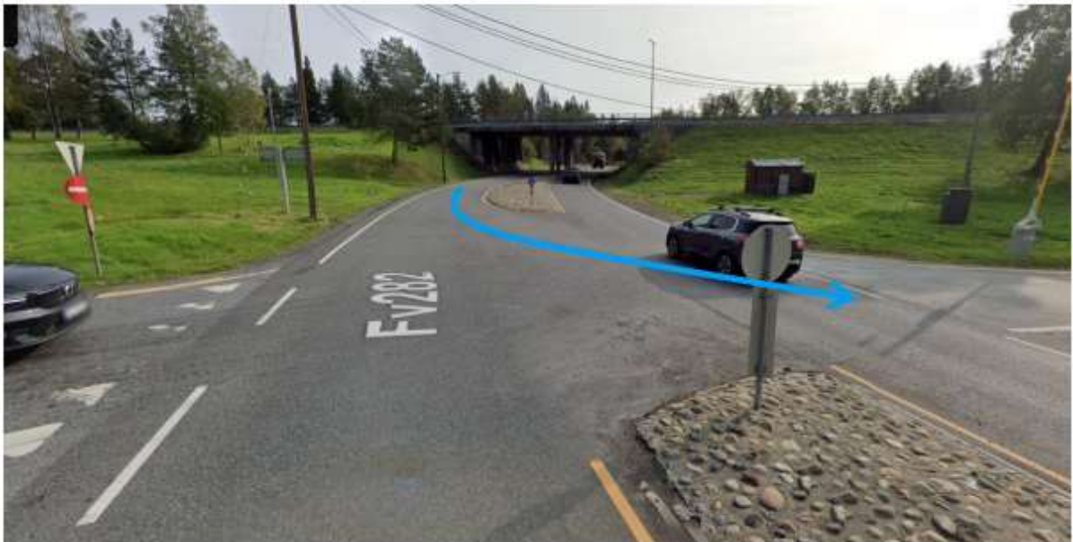
Bildet viser dagens Tranbykryss nord for E18. Blå pil markerer bevegelsen som forårsaker flest ulykker. Bildet er hentet fra rapporten Kapasitetsvurdering Tranbykrysset, utarbeidet av Rambøll.
