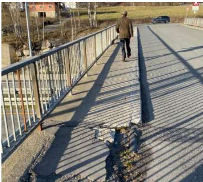
Bildet viser betongbanketten på Heiatoppen bru. Bildet tatt fra sørsiden av brua mot nord.
