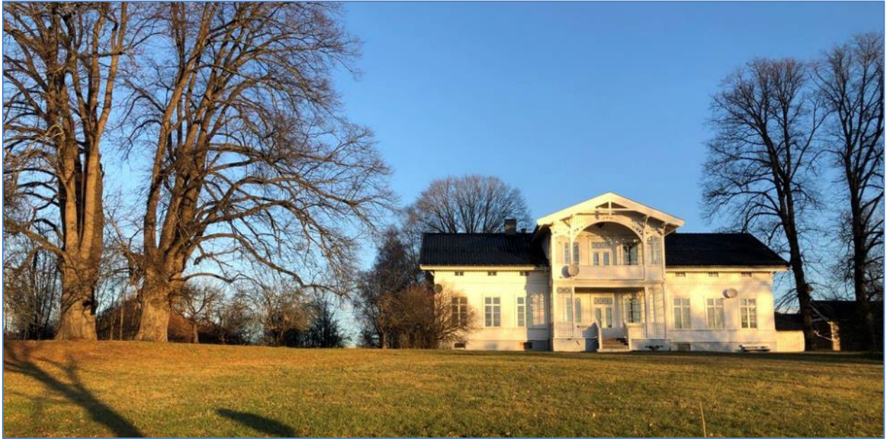
Figur 2-3: Gilhus gård, hovedbygningen mot Gilhusveien (foto: Multiconsult november 2019).
