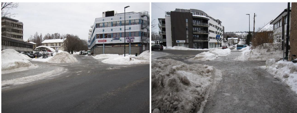
Figur 12: Den brede avkjørselen til parkeringsarealet mellom rådhuset og Rema 1000 (til venstre, sett fra øst) og avkjørselen til baksiden av Bakerikvartalet hvor det er dårlig sikt mellom fortauet og avkjørselen (til høyre, sett fra syd).
