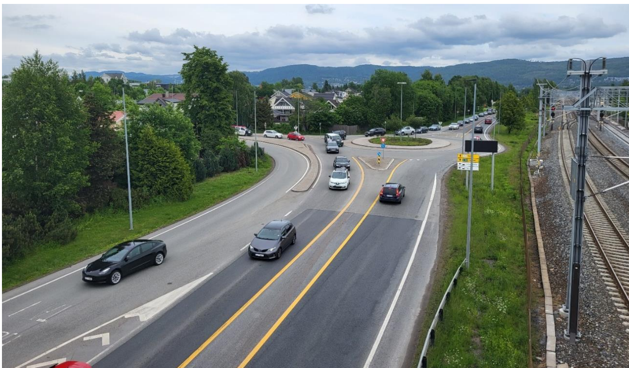
Figur 3-3 Ved saktegående avvikling mot Brakerøyarundkjøringen kan køen stå gjennom rundkjøringen mellom Strandveien vest og Brugaards vei i rushtiden. Kilde: Norconsult.
