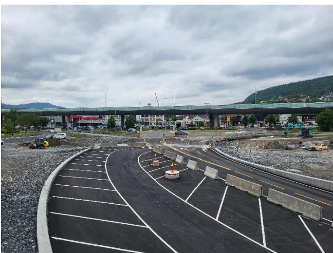
Figur V- 14: Sykehusrundkjøringen under bygging våren 2022
