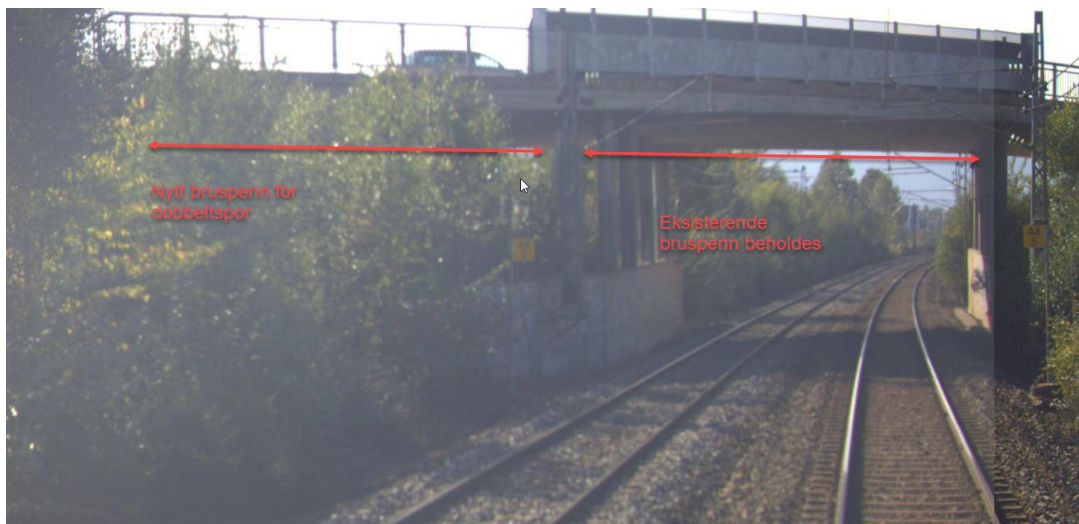
Figur 4-3 Utvidelse av eksisterende veibru E134
