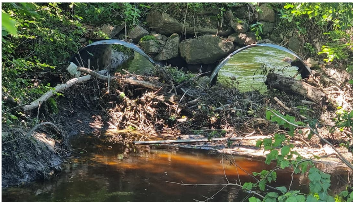
Figur 9 Figur 8 Innløp til Bru 11 ved Vestre Linnes gård i 2024.
