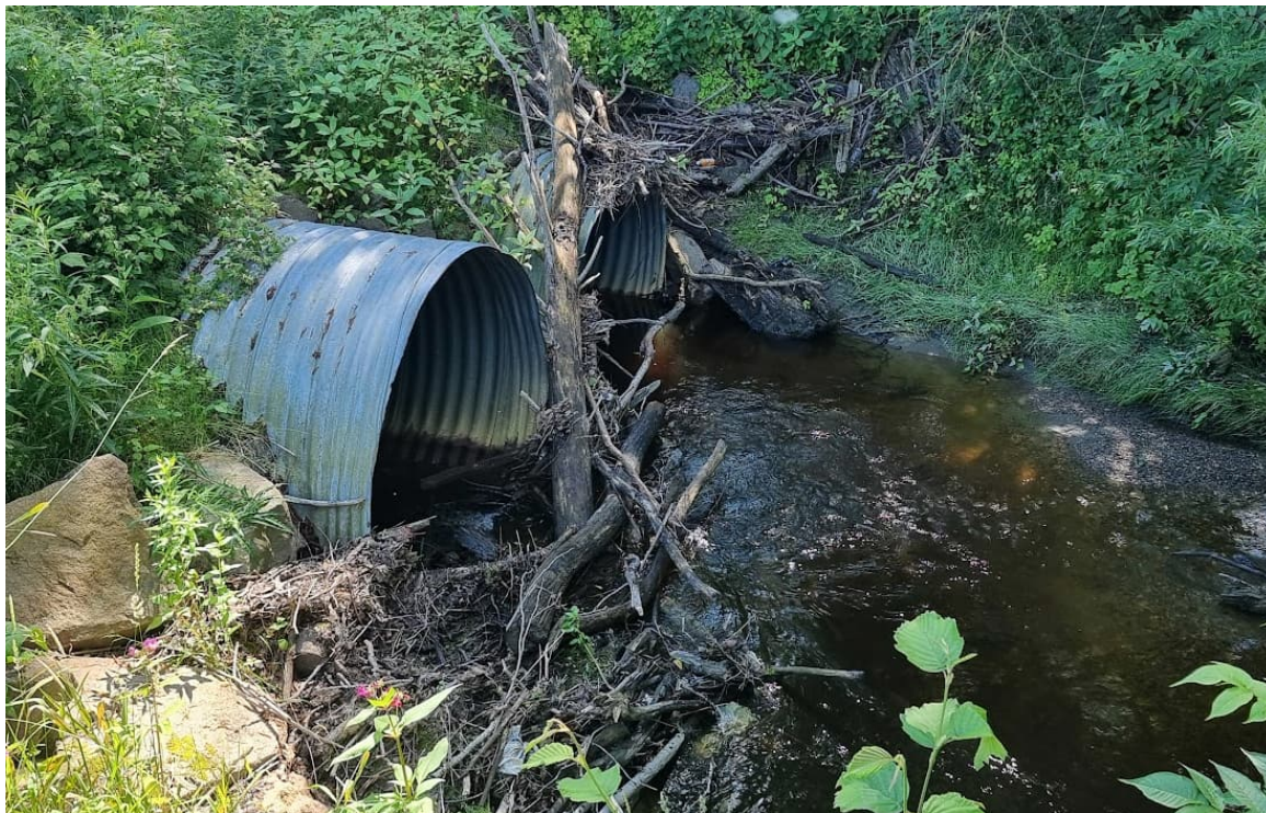
Figur 11 Innløp til Kulvert 3 ved Circle K på E18.
