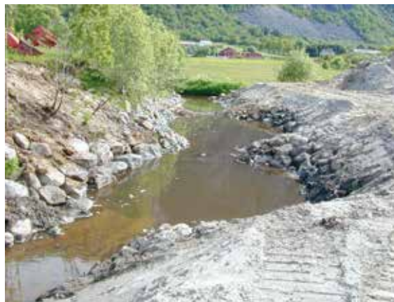
Bilde 44: Midlertidig dam under store jordflyttings- og oppdyringsprosjekter. Foto Atle Hauge
