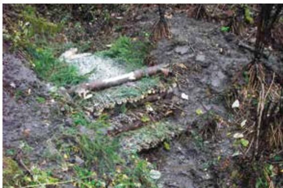
Bilde 17b: Kvistdam som kan legges i ravine for å bremse erosjon og samle sedimenter. Eksempel fra Slovakia.
