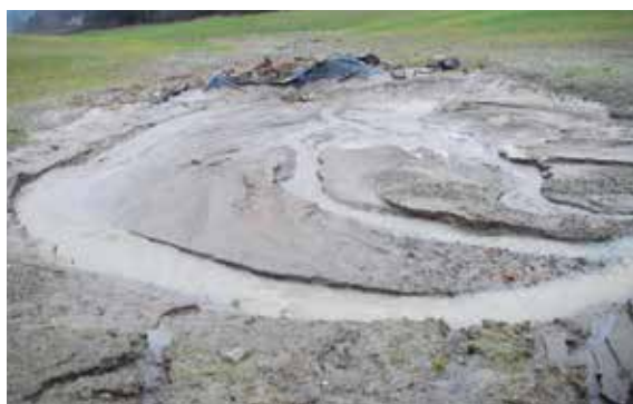
Bilde 34: Kumdammen kan fort fylles opp dersom en får erosjon i dråget. Da har en spart rørledning og vannkilden for mye sediment. Foto Atle Hauge
