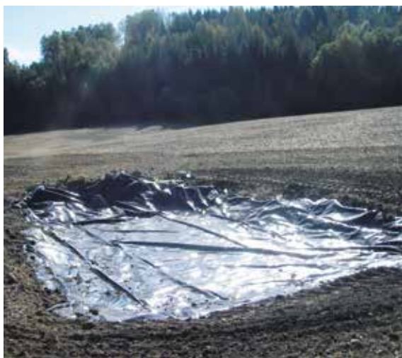
Bilde 33: Kumdam under anlegg. Membranen trekkes helt over kummen, før det klippes hull, og rista settes på. Foto Atle Hauge
