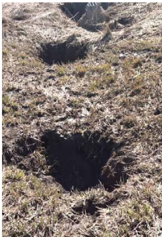
Bildegalleri 21 a-d: Tegn på at det er skader på rørledningen kan ofte sees på overflaten som jordhull eller erosjonsspor på overflaten. Noen ganger er rørledningen helt blottlagt.
