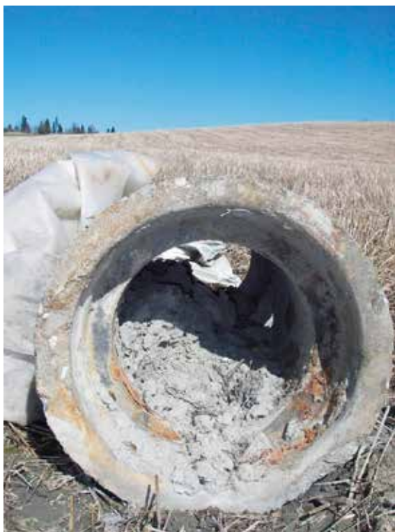
Bilde 25: Utskiftet rør fylt med leire.
