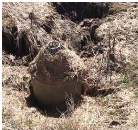
Bilde 32: Selv gode rister kan tettes dersom det er flom og mye løs halm på feltet.
