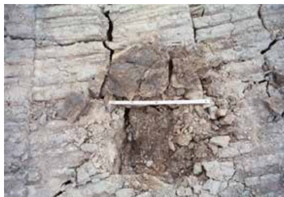
Bilde 43: Jord som er lagt ut ved våte forhold av bulldoser kan være svært pakket og uegnet som voksemedium.
