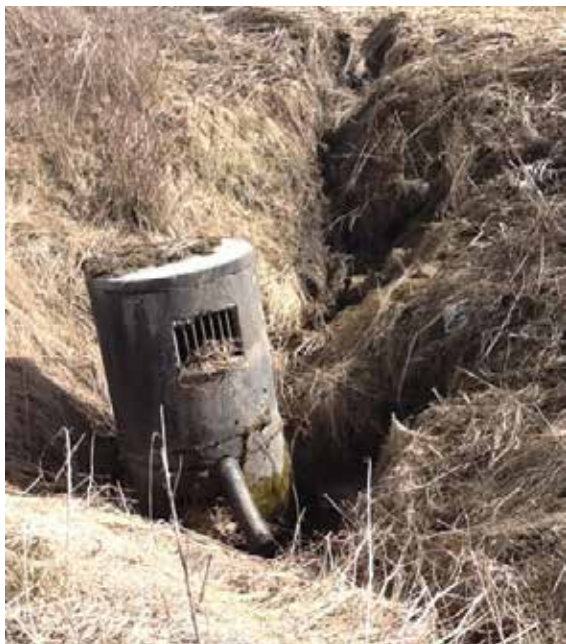
Bilde 38: Frysing og tining, og erosjon kan ødelegge kummene.
