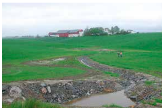
Bilde 18: Gjenåpning av bekkelukking i Rakkestad. Bildet er tatt like etter ferdigstillelse. Foto Atle Hauge
