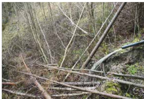
Bilde 10: Rørutløp i raviner bør føres ned til bunnen, ellers kan en sette i gang kraftig erosjon. Foto Atle Hauge
