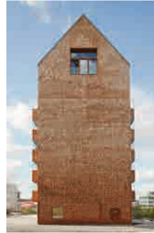
trekledning - shingel - i større hus Sundbyberg strandpark, Stocholm. 8 etasjes boligblokk. Wingårdh Arkitektkontor
