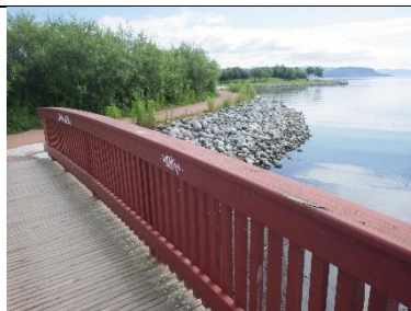
Figur 5-29 Bru over liten kanal.
