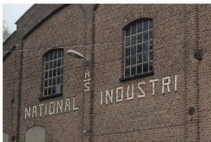
1: Industribygg, som skal rives for å gjøre plass til helseparken og sykehuset. Deler av de kulturhistoriske fasadene gjenoppbygges i forbindelse med helseparken.
