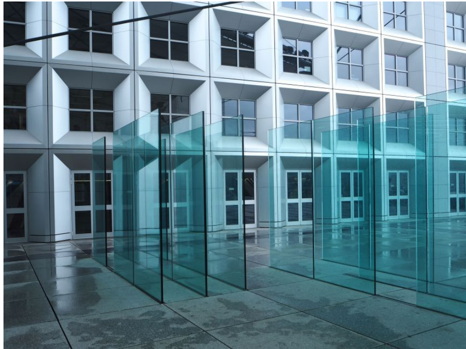
Figur 4 Vindskjerming av inngangsparti.
