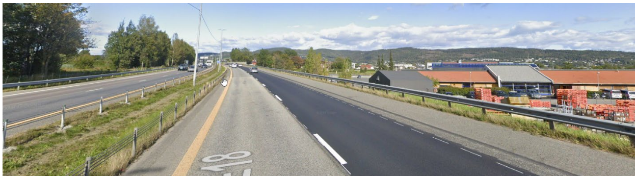
Figur 4-18. E18 motorvei med ÅDT på ca. 35.000 med overvannsanlegg med drenering i midtdeler med sandfang med rist.
