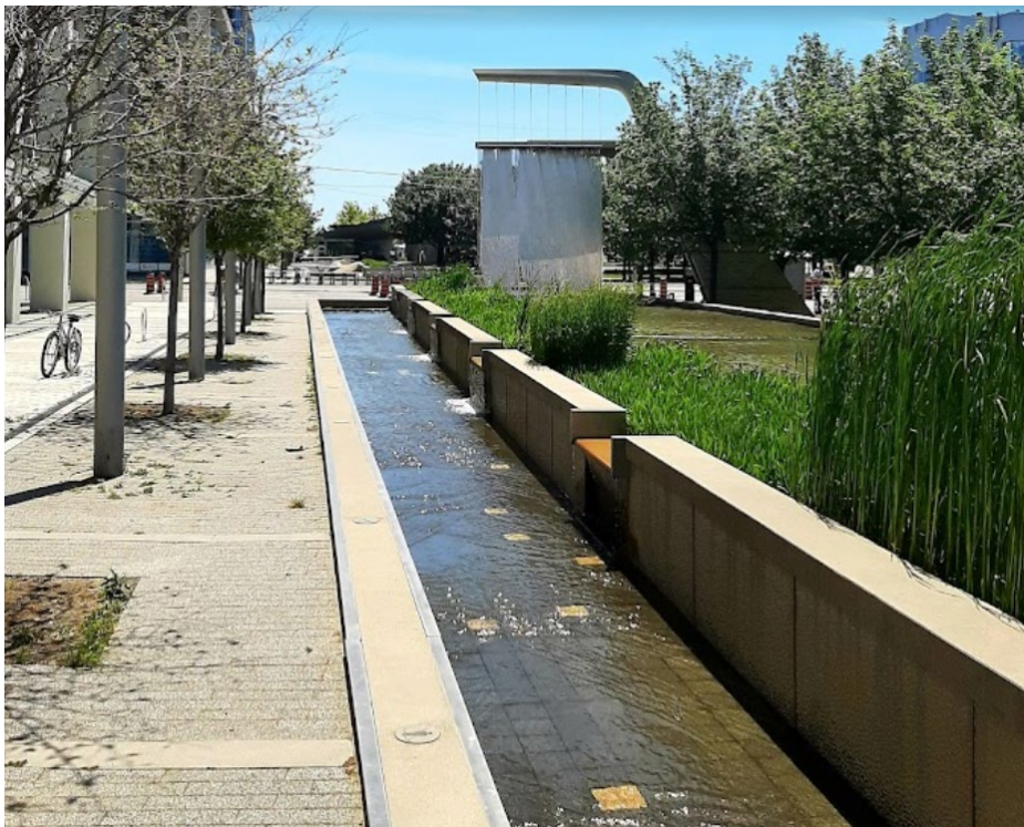
Figur 4-51. Sherbourne Common, Toronto. Overvann faller fra et tårn for å øke oksygeninnhold før det går gjennom et våtmarksfilter og videre i en kanal mot sjøen. Bilde: Jack Wilcan.
