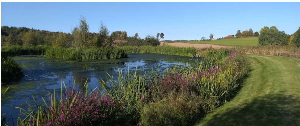
Figur 4-44. Åpne rensedammer i Blåveisebekken rensepark ved Hebekk skole (Ski, Nordre Follo kommune).
