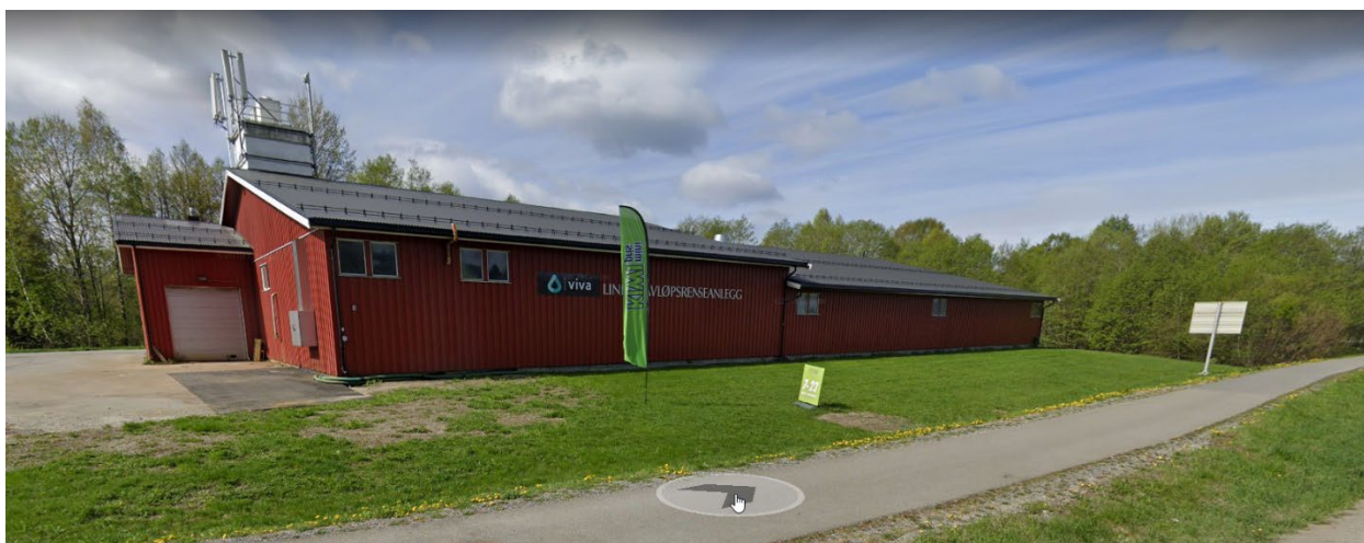
Figur 4-8. Linnes avløpsrenseanlegg. Kilde: Google maps.
