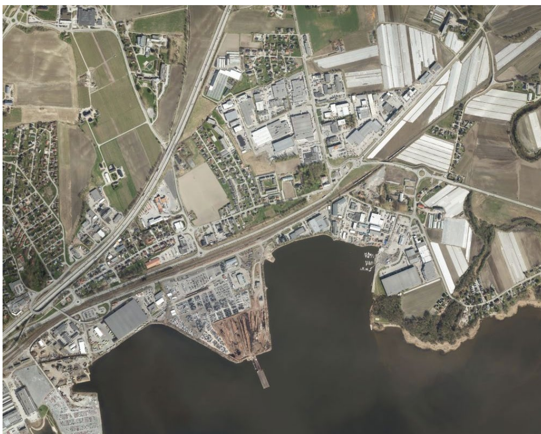
Figur 4-20. Avrenning til Drammensfjorden ved planområdet kommer fra landbruksarealer, motorvei E18 og industriarealer.
