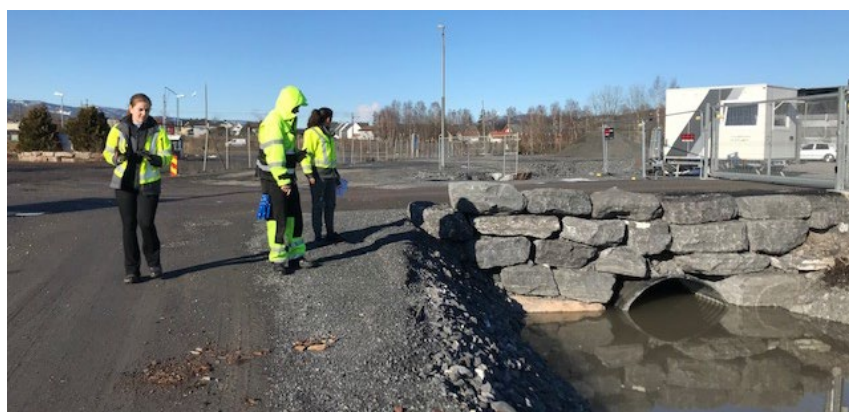
Figur 4-5. Befaring og nedmål av eksisterende overvannsanlegg på Lierstranda.
