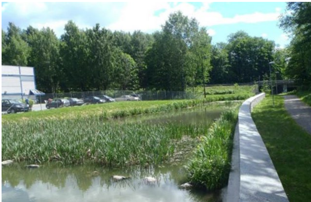
Figur 4-43. Rensepark for avrenning fra Ruud næringspark i Bærum. Kilde: Asplan Viak.
