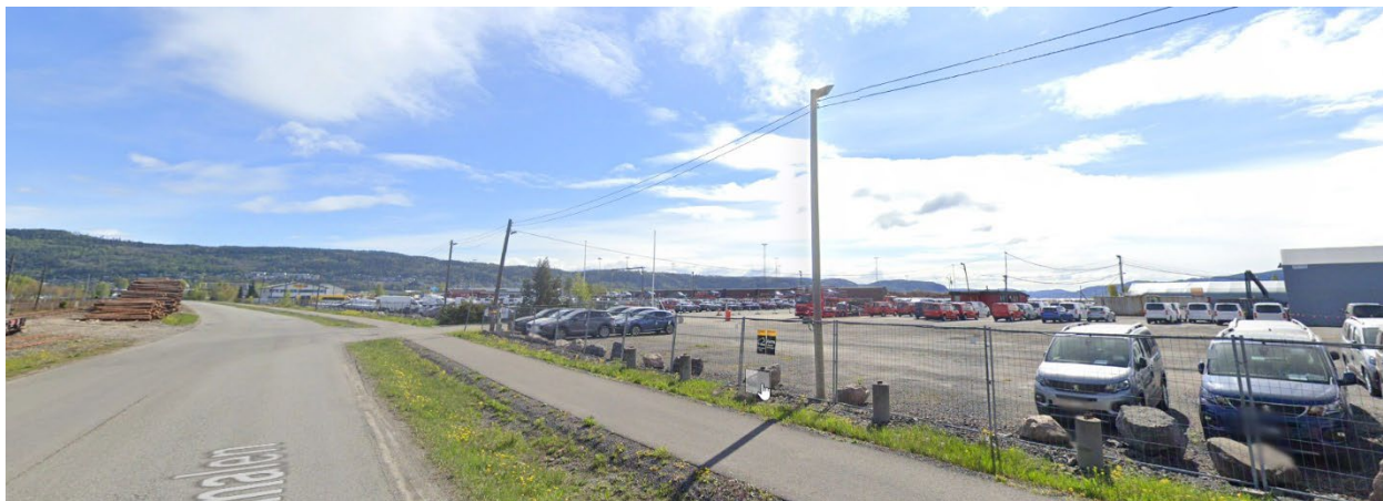
Figur 4-21. Terminalen med næringsarealer som kan få framtidig bruksendring.
