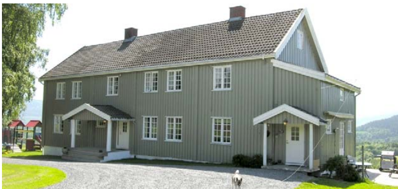
Eldste del av hovedbygningen på Østre Solberg skal være oppført i 1748. Huset ble forlenget omkring 1840.
