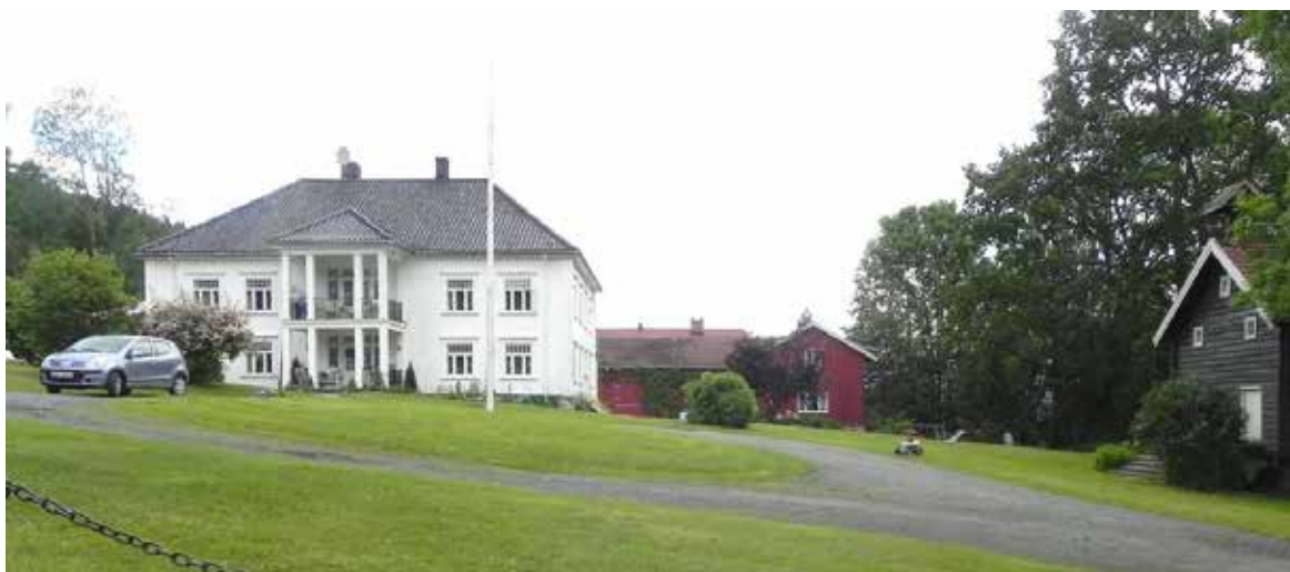
Søndre Horn med en dominerende hovedbygning som skjuler byggetrinn av høy alder innenfor en fasade fra 1909. Buret skimtes ytterst til høyre, og mellom disse ligger sidebygningen.
