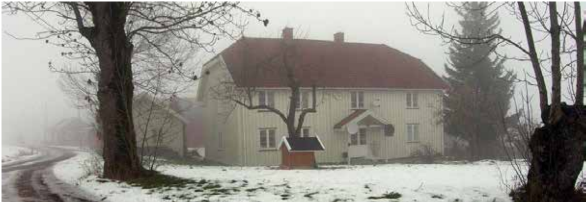
Hovedbygningen på Nordre Eik er en lav toetasjes bygning med halvvalmet tak. Huset skal være reist tidlig på 1800-tallet og er dermed blant de tidlige i rekken av empirehus i Lier.
