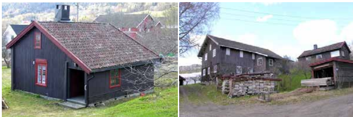
Stuebygningen har svalgang langs den ene langveggen. Bryggerhuset (til høyre) er noe modernisert, men vesentlig for helheten i anlegget.
