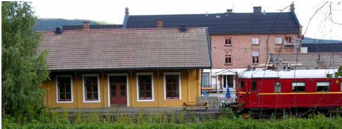
Lier stasjon sto ferdig til Drammensbanens åpning i 1872, og ble tegnet av Georg Andreas Bull. Lier meieri, lenger bak, ble reist i 1884 og påbygd 1900. Begge bygninger er en del av liungenes identitet.
