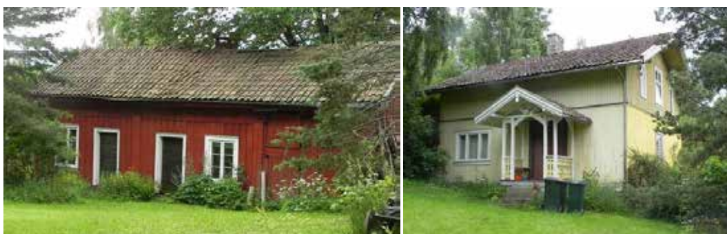
Dalengas bryggerhus (til venstre) og hovedbygning i sveitserstilsdrakt.
