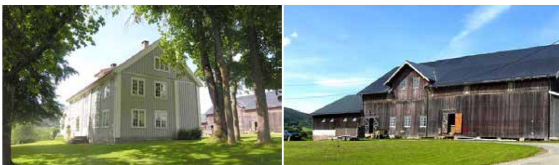
Laftekassene indikerer en planløsning som kan være bestemt av formen på et enda eldre hus med svalgang.
