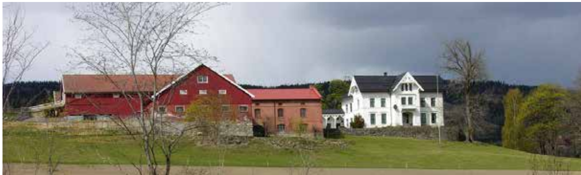
Tunet sett mot sør med driftsbygning med fjøs tverrstilt i terrenget, meieribygning og hovedbygning.
