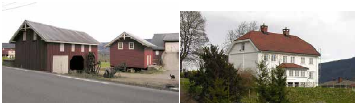
Vedskjul (til venstre) av denne typen er meget sjeldent i Lier. Hovedbygningen på det søndre bruket (til høyre) er blant de eldste hus i Lier.
