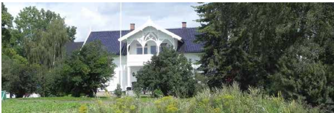
Hovedbygningen på Søndre Huseby er typisk for sveitserstilens halvannen etasjes våningshus med dekorglede og løvsagarbeid av høy kvalitet.
