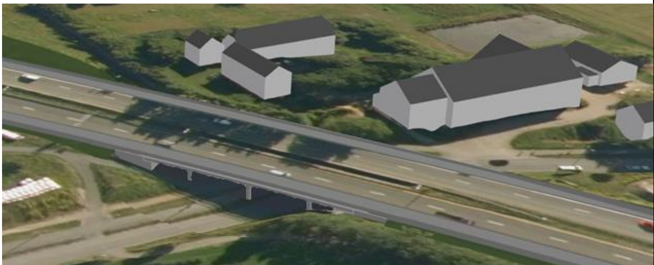
Figur 3-10 3D modell K1101 Breddeutvidelse av eksisterende bruer. Til orientering ligger Jensvoll gård midt i bildet.
