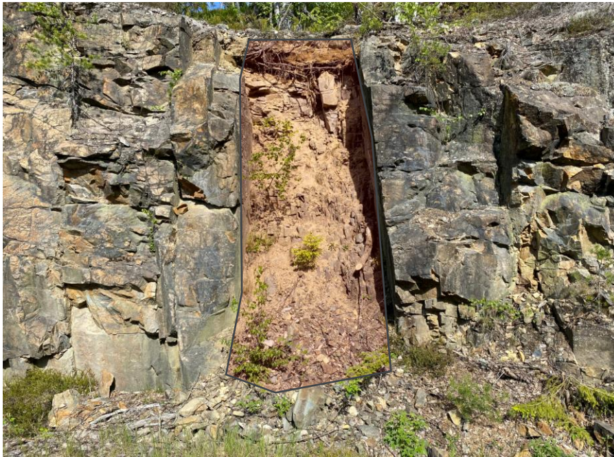
Figur 5-10 Diabasgang (markert i rødt) fremstår som veldig forvitret. Bildet sett mot NNØ.
