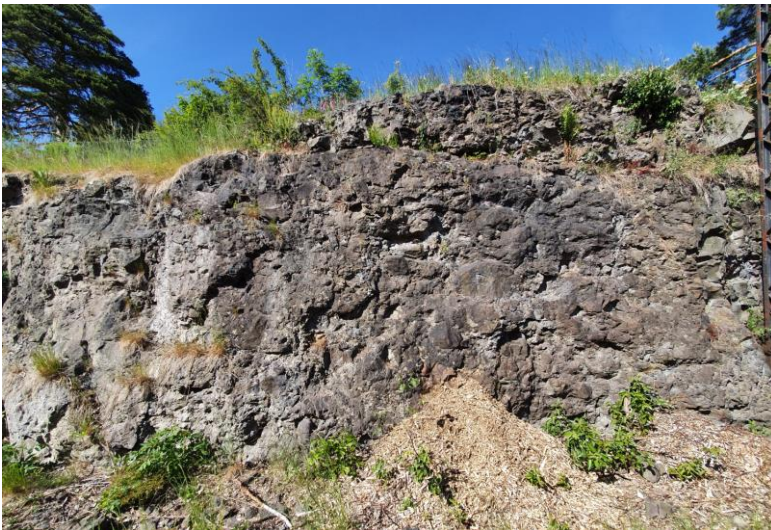
Figur 5-9 Bildet tatt fra bergskjæring øst for Reistad. Sprekkesystemet i syenittporfyr fremstår rotete.
