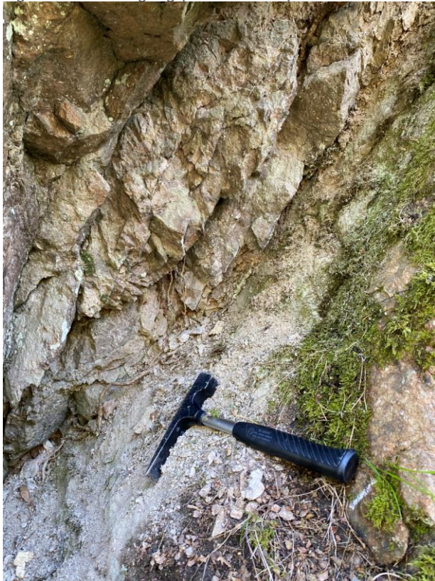
Figur 5-11 Forvitringssone med leire belegg. Bildet sett mot SV hvor sonen har strøkorientering langs NØ-SV med steilt fall mot SØ. Sideberg av sonen fremstår som mykt og svakt og kan lett smuldres opp med fingrene.
