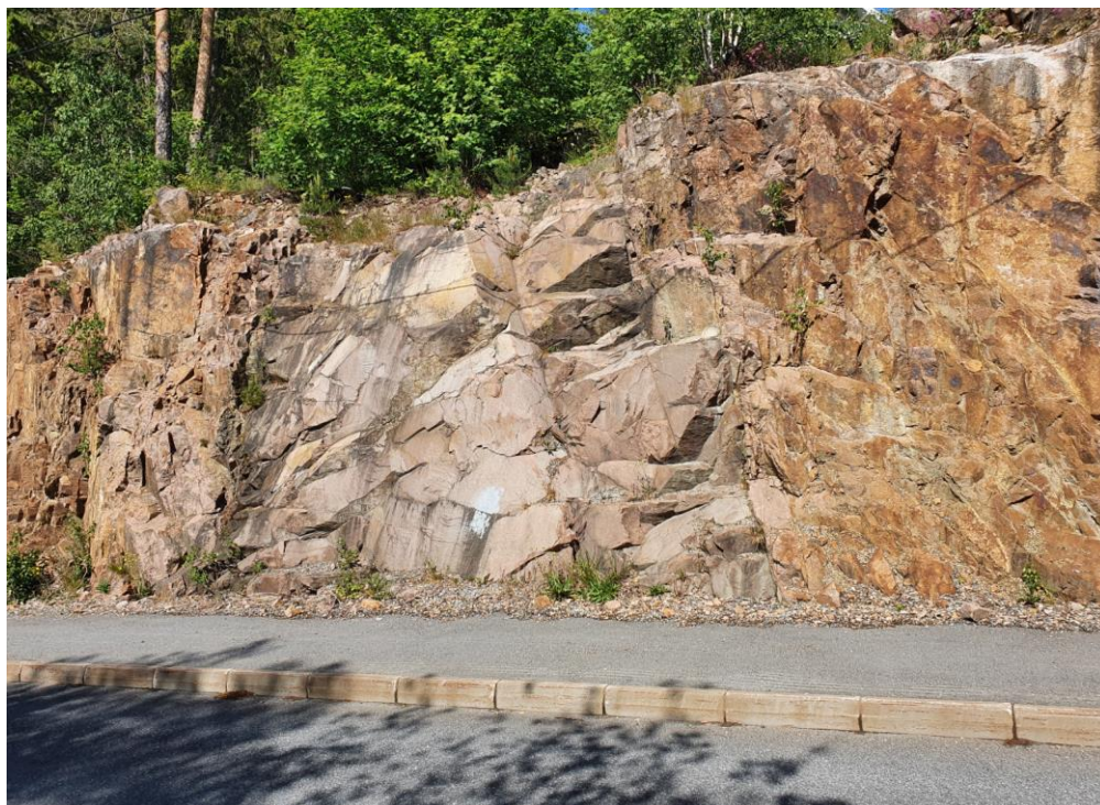
Figur 9-9 Bilde fra Linneshakken syd for planlagt vestre påhugg. Bildet viser bred diabasgang samt forvitret granitt med rustutfelling.
