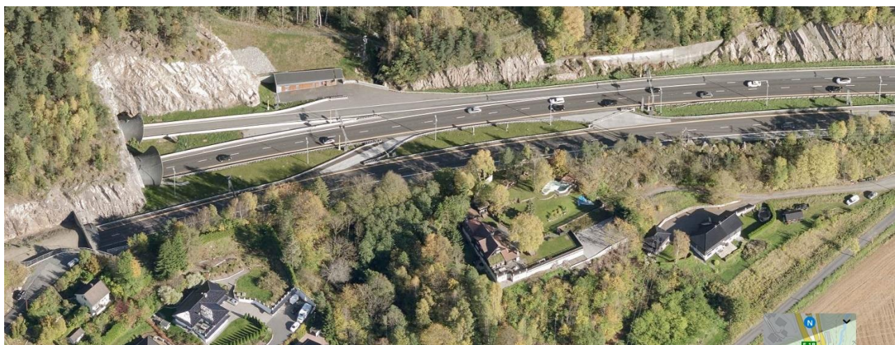
Figur 5-6 Lierbakkene motorveg ved innløpet til tunnelene [28]
