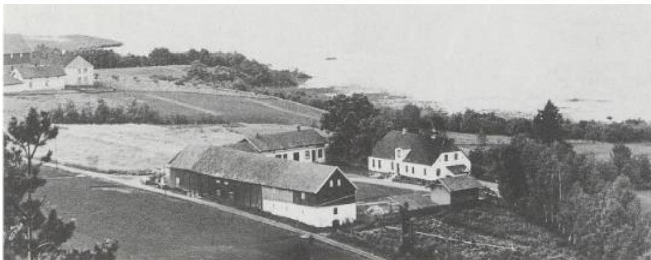
Figur 5-39 Eldre bilde av Nordre Gullaug. Gården Mellom Gullaug, revet i 1990, sees i bakgrunnen [21]
