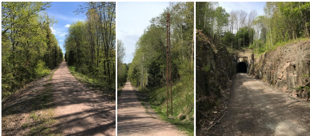
Figur 5-3 Til venstre fyllingen over Daueruddalen, i midten en mast i dette området. Til høyre Kovestadtunnelen
