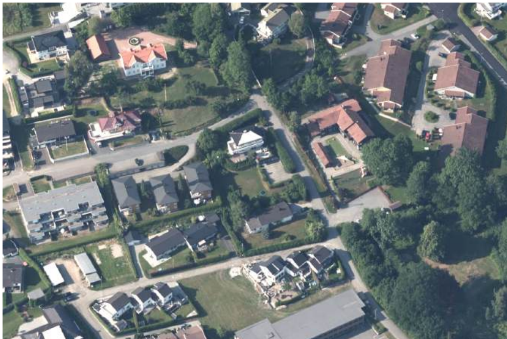
Figur 15. Bebyggelsesstrukturer nord og vest for planområde. Lavblokker, tomannsbolig, rekkehus, barnehage og bofellesskap.
