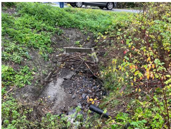
Bildet til venstre viser at kulvert under fylkesveien er tettet igjen med kvist og grus. Bildet til høyre viser kulvertutløpet nedstrøms fylkesveien og inntaket til den private kulverten (Foto: BFK)
