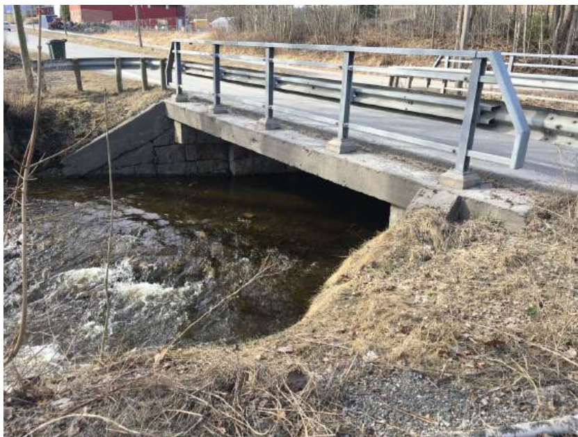
Bilde av dagens bru sett fra øst (foto: Buskerud fylkeskommune, mars 2022).
