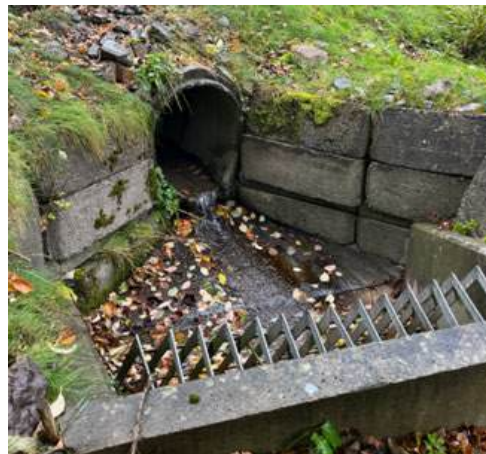
Bildet til venstre viser at kulvert under fylkesveien er tettet igjen med kvist og grus. Bildet til høyre viser kulvertutløpet nedstrøms fylkesveien og inntaket til den private kulverten (Foto: BFK)
