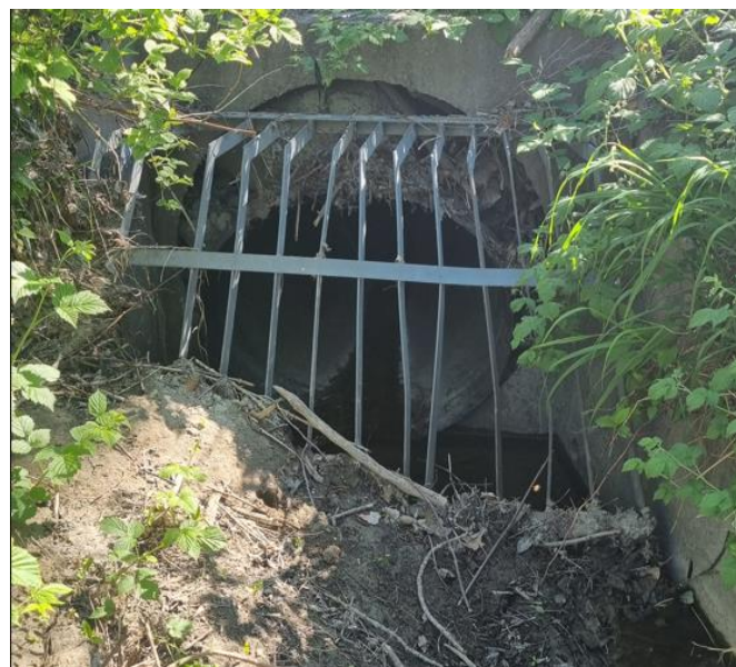
Figur 6-4- Utløpet fra kulvert 1 ( \varnothing 1000 mm), høyre side/ Innløpet til kulvert 2 PE \varnothing 900 mm, venstre side.
