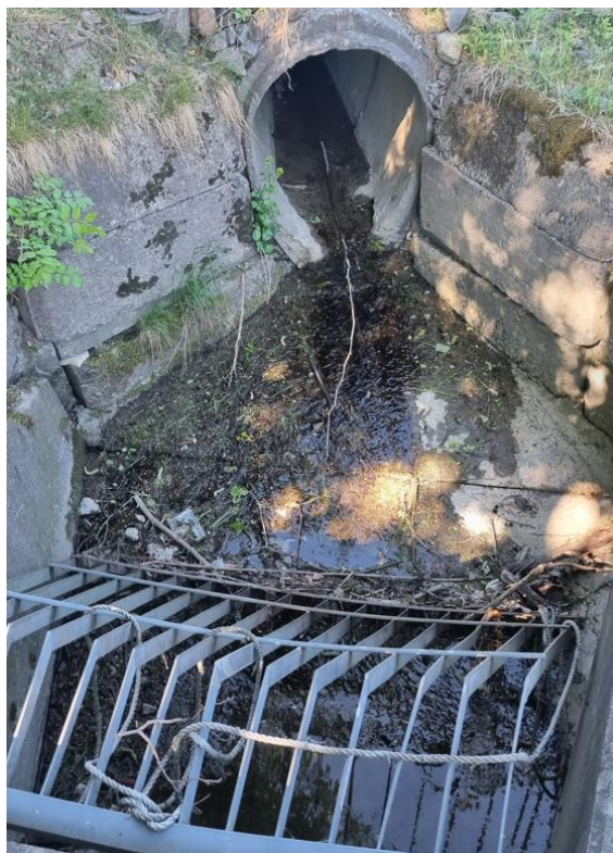
Figur 6-5-Utløpet fra Kulvert 2 (ellipse 85x70), og innløpet til kulvert 3 PE \varnothing 600 mm.
