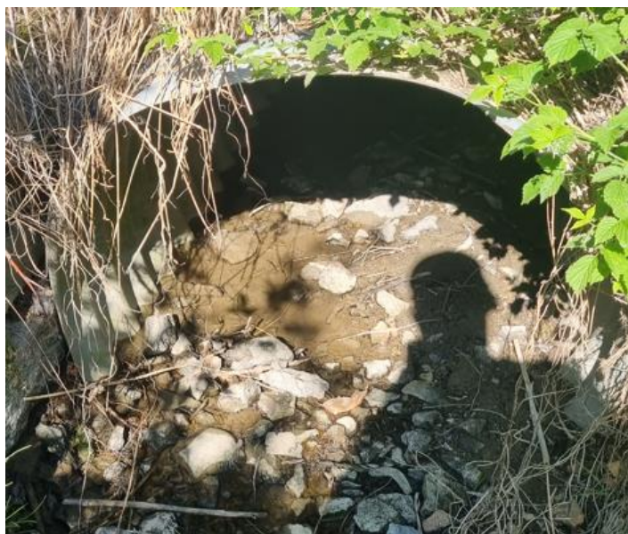
Figur 6-4- Utløpet fra kulvert 1 ( \varnothing 1000 mm), høyre side/ Innløpet til kulvert 2 PE \varnothing 900 mm, venstre side.
