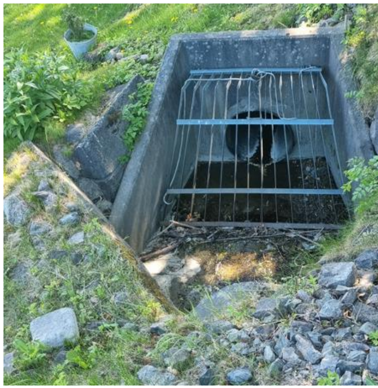
Figur 6-5-Utløpet fra Kulvert 2 (ellipse 85x70), og innløpet til kulvert 3 PE \varnothing 600 mm.
