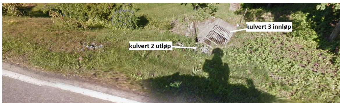
Figur 6-3- Innløp til kulvert 3, sett fra Nøsteveien.
