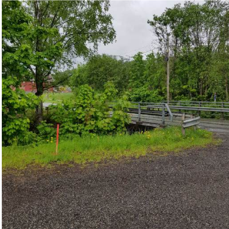
Fig.5: Situasjonen ved borpunkt bh07 ved siden av huset Nøsteveien 90 hvor det går en forgrening av Nøsteveien mot øst, på østsiden av FV2704 Nøsteveien, utstikking av borpunkt ved siden av Sandakerelva (nord for), synsretning mot sørvest
