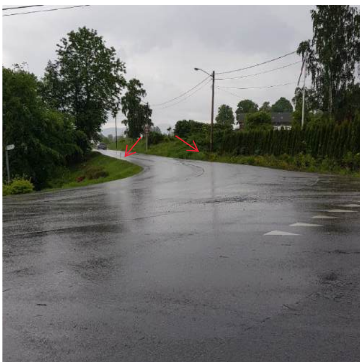
Fig.16: Situasjonen ved borpunktene bh13 (til venstre, øst) og 21 (til høyre, vest) i nærheten av kryssområdet Nøsteveien / Kirkeveien ganske i nord, utstikking av borpunktene langs vegkanten ved toppen av den skråningen (13) av vegfyllingen og ved siden av Kattingbekken-kulverten (21), synsretning mot sørvest, flatt til skrånende terreng
