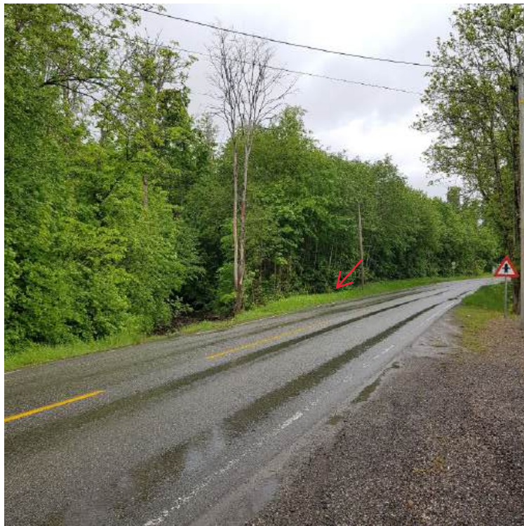
Fig.8: Situasjonen ved borpunkt bh18 ved på vestsiden av FV2704 Nøsteveien, utstikking av borpunkt ved siden av Sandakerelva (nord for), synsretning mot nord
