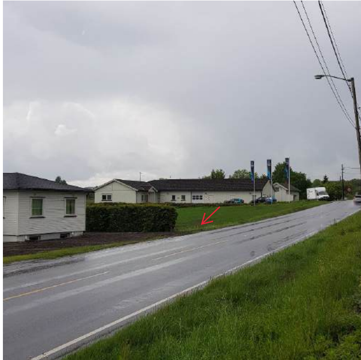
Fig.3: Situasjonen ca. ved borpunkt bh05 ved siden av huset Nøsteveien 78A på østsiden av FV2704 Nøsteveien, utstikking av borpunkt ved siden av hekken ved foten av den lille skråningen av vegfyllingen hvor gang- og sykkelveien skal ligge på lav fylling, synsretning mot sørøst, flatt terreng
