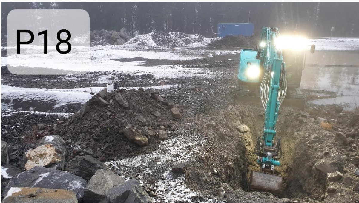
Figur 7. Fra graving av prøvesjakt P18. Grusige fyllmasser med til dels mye stein.
