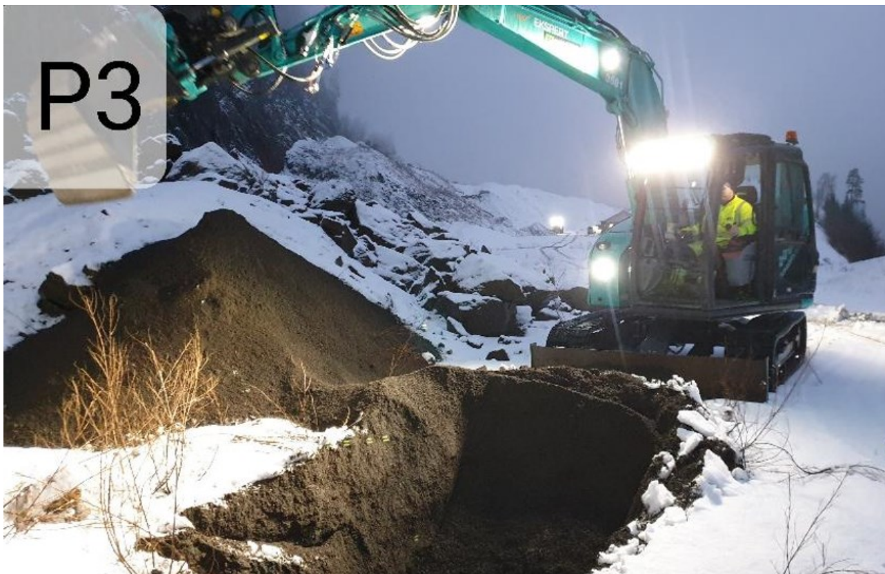
Figur 5. Fra graving av prøvesjakt P3. Som bildet viser er det sandige grusmasser i hele sjiktet som er undersøkt.
