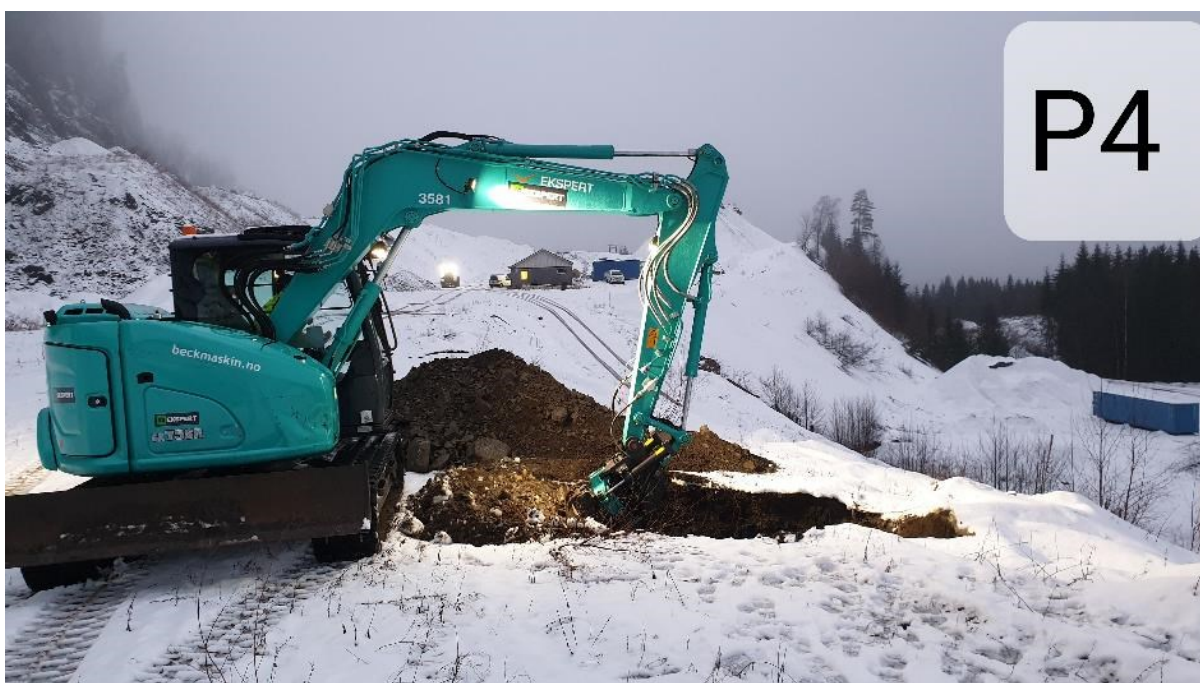
Figur 6. Fra graving av prøvesjakt P4. Sandige grusmasser med til dels mye stor stein.
