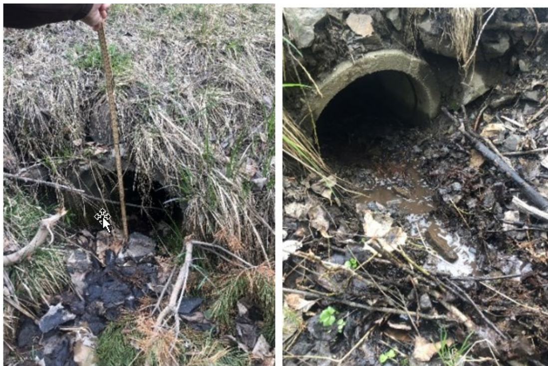
Figur 6: Eksisterende 300 mm betongstikkrenne sør for avkjørsel til massedeponiet. Til venstre: innløp. Til høyre: utløp, delvis fylt opp med jord og grus. Bilde tatt under befaring 07.05.2020.
