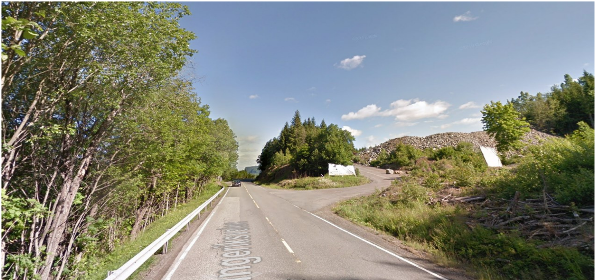
Figur 3-3: Fv. 285 (Ringeriksveien) ved avkjørsel til massetak ved Toverud, sett mot nord [9] .
