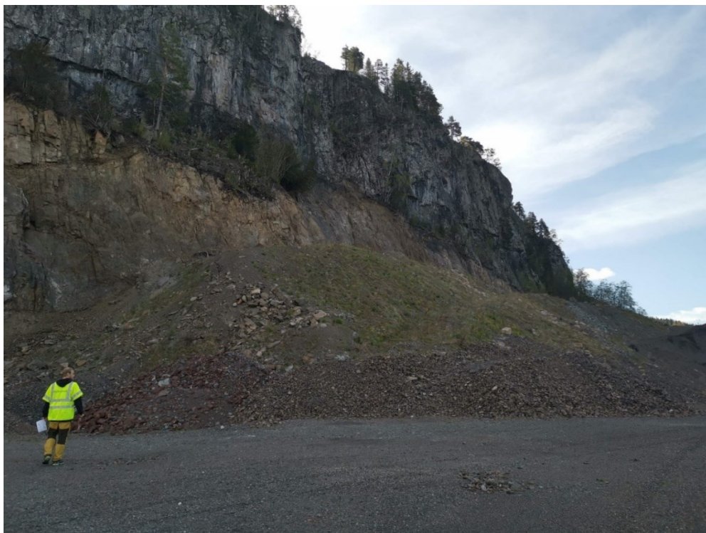
Figur 2-7: Haug med fyllmasser i underkant av den steile bergveggen. Bildet tatt fra posisjon 4 mot sør-øst
