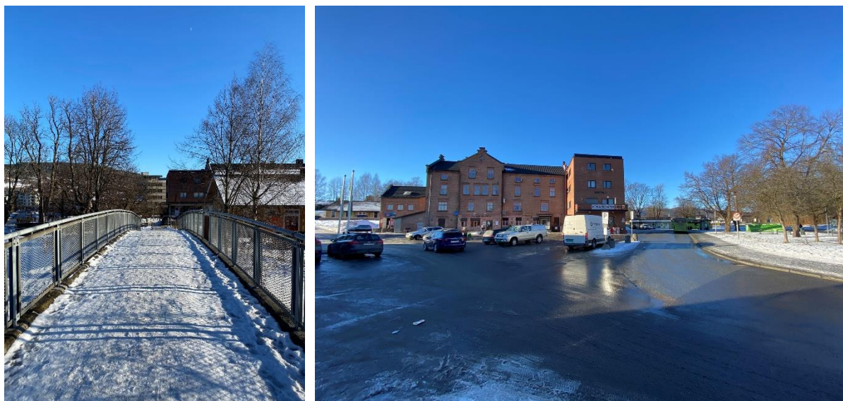
Figur 1-1 Venstre: Gangbrua over fylkesveien er smal, og veiene som leder opp til den er trange og bratte. Høyre: Området rundt dagens bussterminal er preget av utflytende kjørearealer med lange kryssingsavstander for gående og syklende.
