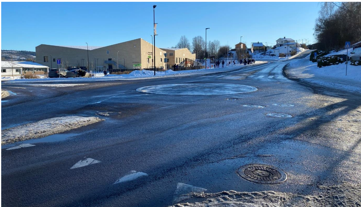
Figur 1-4: Rundkjøringen ved skolen mangler kantsteinsvis (det er liten eller ingen høydeforskjell mellom arealer som er tillatt for kjøring og øvrige arealer). Det gjør at utformingen ikke har noen vesentlig fartsdempende effekt på biltrafikken.
