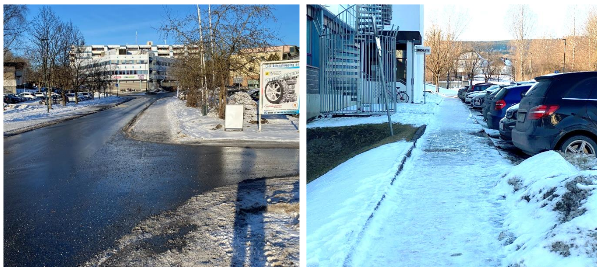
Figur 1-2 Venstre: Avkjørsel utformet som kryss. Her må man være lokalkjent for å vite at de som kommer fra avkjørselen har vikeplikt. Høyre: Fortauet forbi Politistasjonen i Bruveien har en effektiv bredde på bare ca. 1 meter. Bilene parkeres slik at overhenger tar av det allerede smale fortausarealet.
