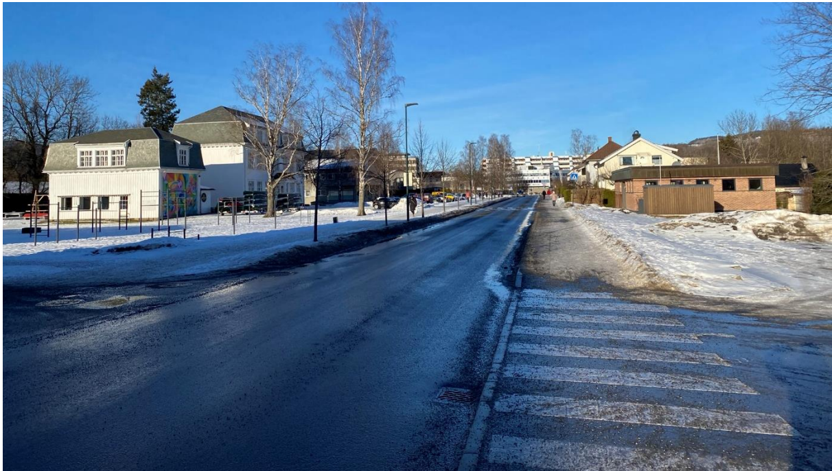
Figur 1-3: Avkjørlene til bensinstasjonen har oppmerkede gangfelt. Dette kan skape usikkerhet om vikepliktsforhold dersom barn sykler på fortauet til og fra skolen. Syklende har normalt vikeplikt der det er gangfelt, men ikke her.
