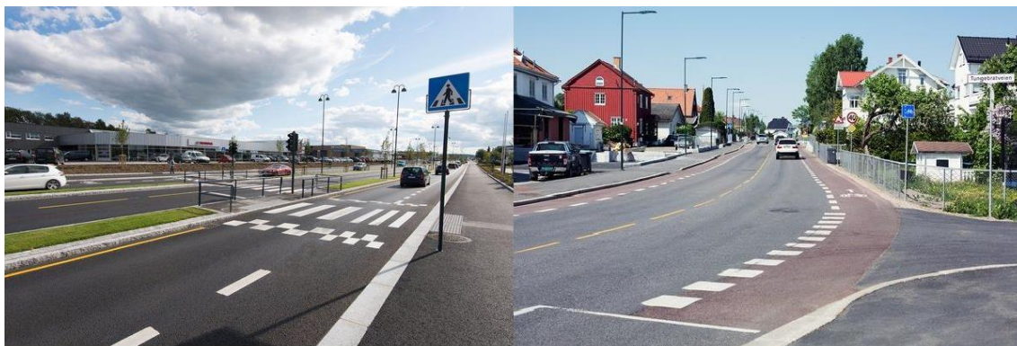
Figur 1: Eksempel på reasfaltert fortau og vei, med utskiftet kantstein. I disse tilfeller vist med sykkelfelt i tillegg. Gode referanser til Bruveien og nedre Hegsbrovei. Foto og prosjekt: Asplan Viak
