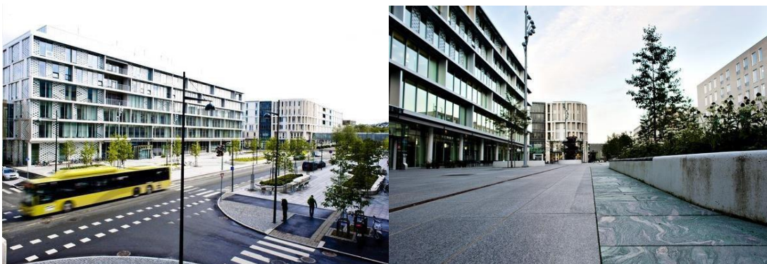
Figur 3: Eksempel på gateløp av høy standard. Brosteinsbelagte fortau med separerte sykkelveier, grønt-rabatt med belegningsstein, ny kantstein og vegetasjon. Gode referanser til standard på Vestsideveien og ny bussterminal. Foto og prosjekt: Asplan Viak
