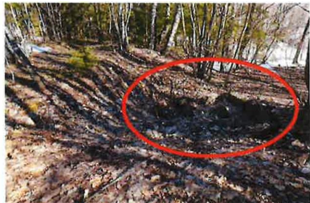
Bilde 6. Viser den i gjenfylte gruvesjakten.
