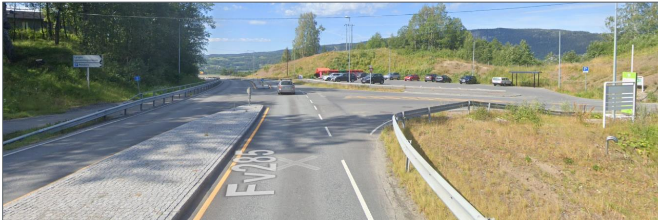
Figur 2-5: Krysset Ringeriksveien x Lyngåsgata, sett fra øst (Kilde: Google Street View, tatt juli 2019)
