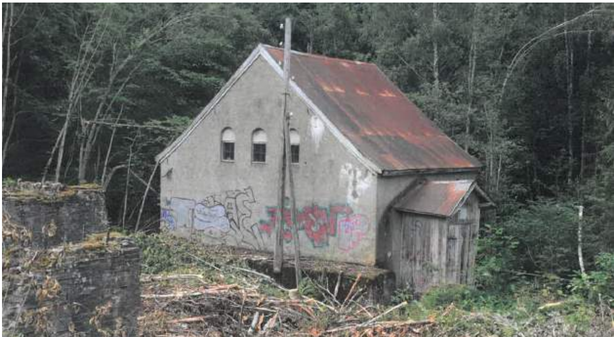
Figur 6-9 Den gamle kraftstasjon står fortsatt ved Glitras bredd.
