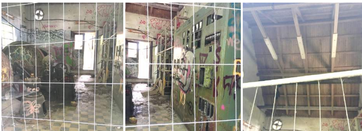
Figur 6-10 Interiør i bygningen. Det som trolig er turbin og fordelingsskap står igjen i bygningen. Takkonstruksjonen er synlig. Taket er uisolert.
