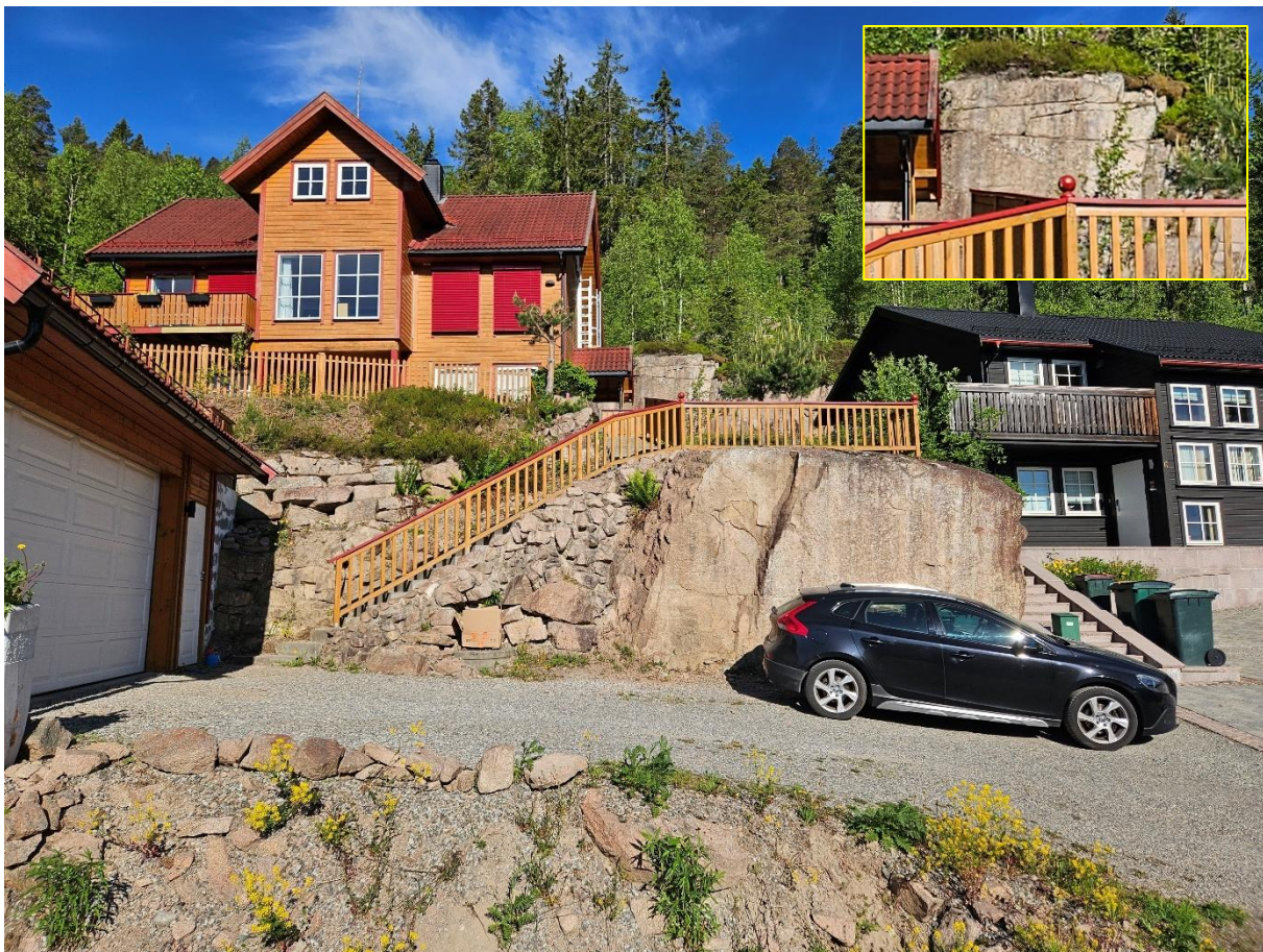
Figur 9: Bergart viser liten oppsprekking og lav sannsynlighet for utfall. Detaljbilde av bakre skrent oppe til høyre viser horisontalt sprekkeseett.
