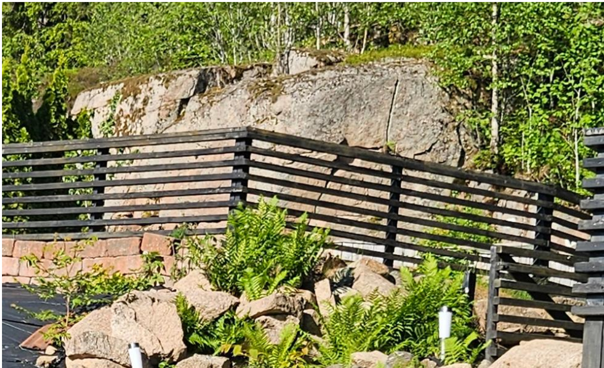
Figur 10: Oppsprekking hvor utfall ikke kan utelukkes.
