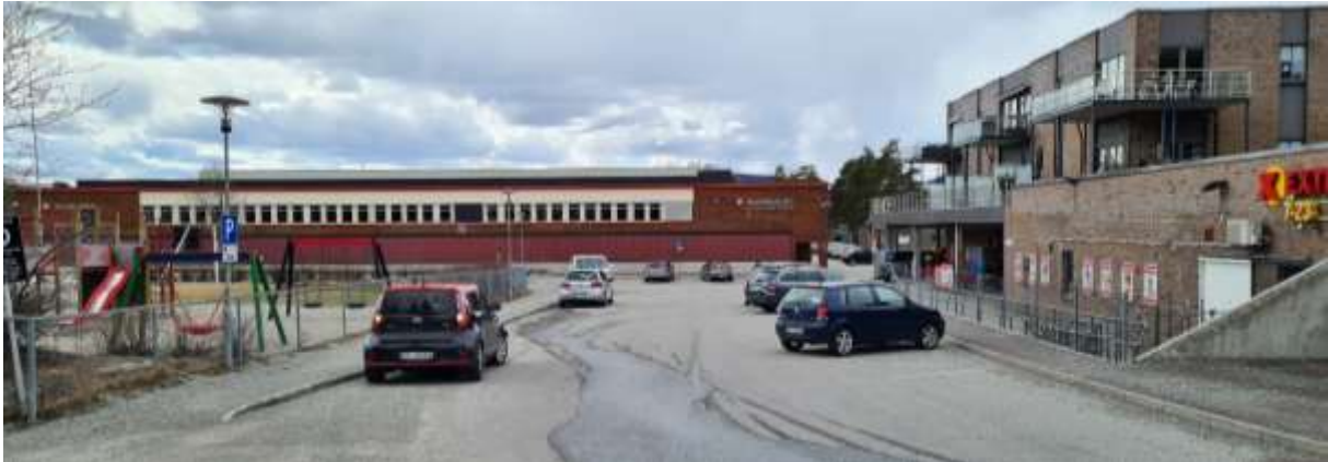
Figur 2. Nedkjøring Tranby torg, med eksisterende dagligvareforretning til høyre og Tranby ungdomsskole i enden. Arealet inneholder i dag både snuplass, slippsoner og parkeringsplasser.
