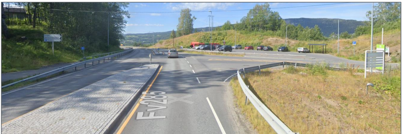
Figur 2-4: Krysset Ringeriksveien x Lyngåsgata, sett fra øst (Kilde: Google Streetview, tatt juli 2019)
