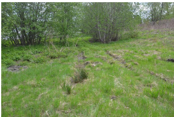
Figur 10. Liten bæreevne i svært fuktige leirmasser ga dype beltespor ved kjøring med gravemaskin (Foto: Trond Knapp Haraldsen).
