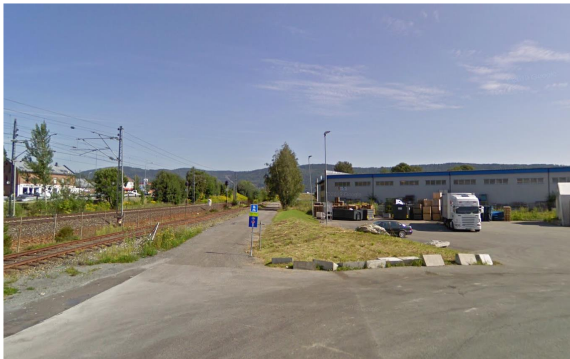
Figur 5-5: Dagens avslutning av Terminalen. Her er det gang- og sykkelvei videre 200 m fram til Gilhusveien. På denne strekningen må det etableres kjørevei dersom veisystemet på Lierstranda skal åpnes mot øst (Foto: Google Maps)
