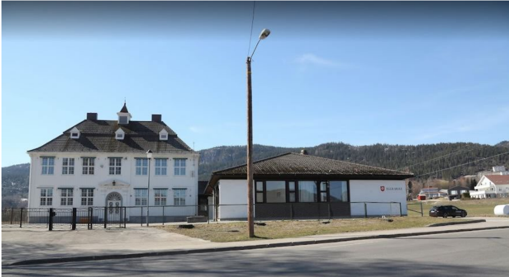
Figur 3: Bildet viser eksisterende situasjon sett fra fylkesveien i øst inn mot skolen og planområdet.
