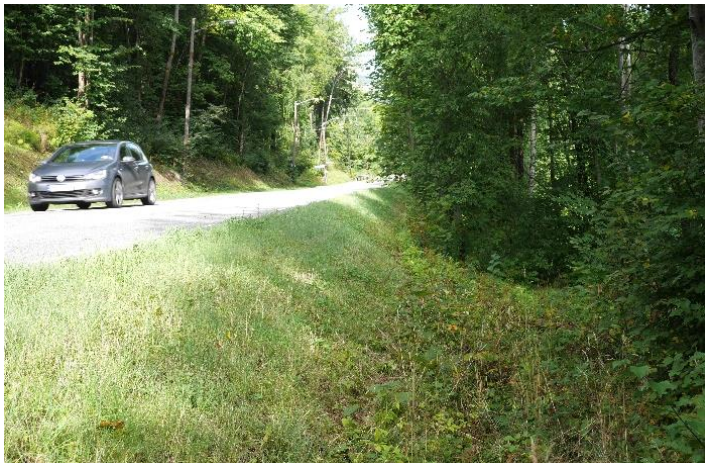
Skråning ned mot elva (østsiden)
