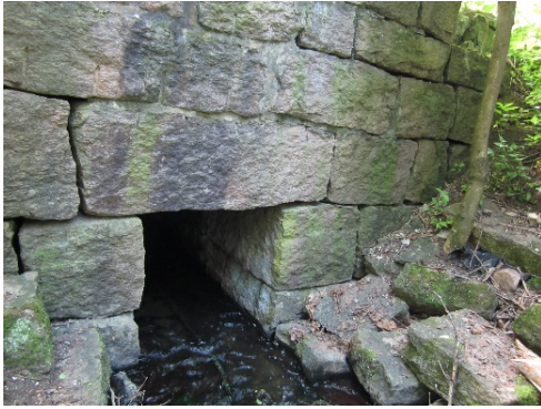
Bilde 11 og 12. Eksisterende steinkulvert skal erstattes med stikkrenne. Stein skal forsøkes benyttet i ny mur mot hage på eiendom 158/4.
