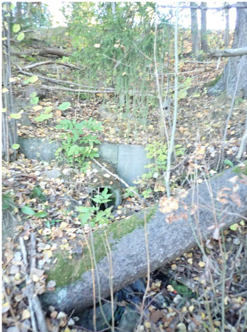
Figur 6 Nødoverløp til terreng
