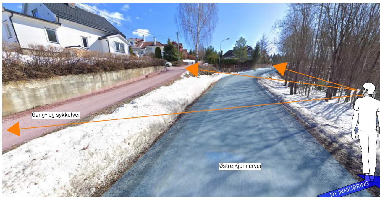
3. Utsyn fra ny avkjørsel mot sør: Det er oversiktig utsyn mot Østre Kjennervei og gang- og sykkelveien
