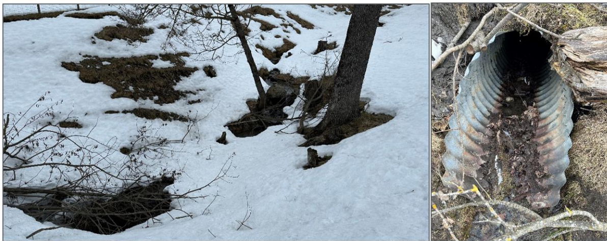
Figur 11-27: Til venstre: Hårbergbekken i krysningspunkt nr. 3. Til høyre: Utløp fra kulvert direkte nedstrøms tiltaksområdet.
