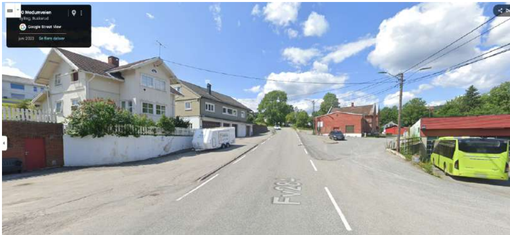
III. 08: Sylling sentrum fra Modumveien mot vest. Ysteriet/Meierietygget og eksisterende bussgarasje til høyre. (Kilde Google Maps).
