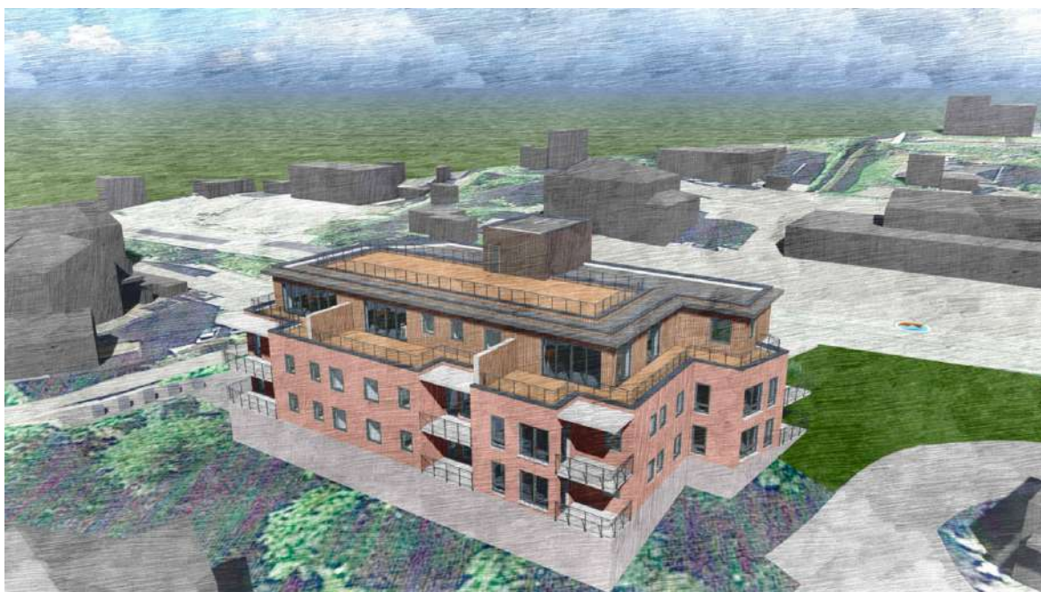
Ill. 23: Prosjekt BBB2- perspektiv høyt fra nord. Heis-/trapperom med maks BYA 40 m 2 med atkomst til felles uteplass/takterrasse har maks høyde ca 3,5 meter over tillatt maks høyde i reguleringsplanen (Kote 137,33) Heis/trapperom er tilbaketrukket og vil ikke kaste skygge på naboer i nord. Øverste etasje er tilbaketrukket 4,0 meter mot nord og vil heller ikke kaste særlig skygge på naboer i nord.
