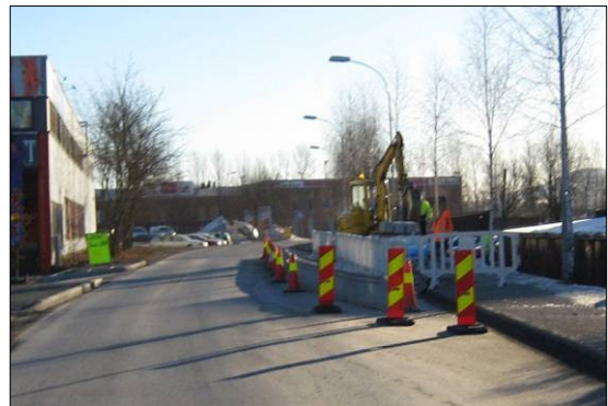
Riktig utført sikring og varslings.
