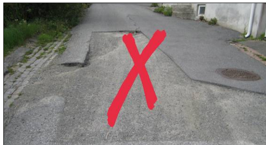
Feil utført skjæring; Entreprenør har midlertidig ansvar for vedlikehold av dekket.
