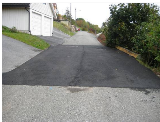
Riktig - etter pålegg om endring.
