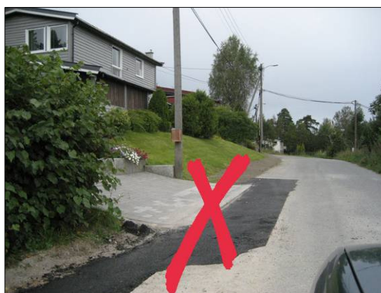
Uønsket endring av grøftetrasé.
