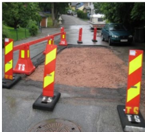
Sikring av gravested.
